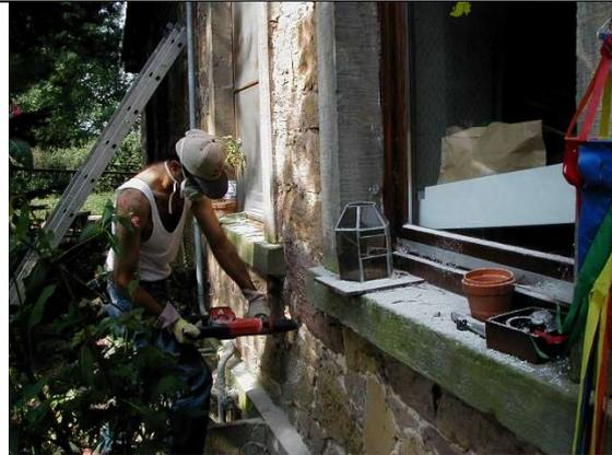
**D:** Nun kann die Dicke des Hohlraumes gemessen werden zwischen dem Daumen/Zeigefinger und der Stelle, an der der Draht in der Wand verschwindet (beim gezeigten Beispiel: 8 cm)
