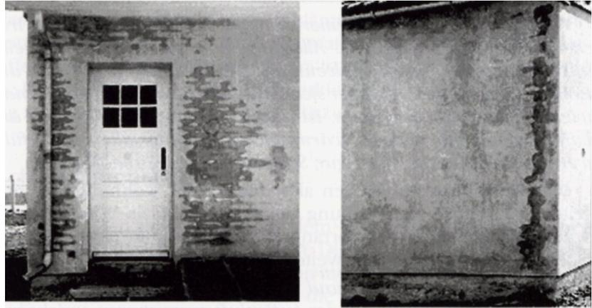
**Bild 2:** Zweischalige Wände mit Luftschicht im Versuch. Der Wasserdampf strömt in der Luftschicht um das Haus und durchnässt die Aussenschale der kältesten Gebäudebereiche durch Kondensation. Versuchsgebäude in Holzkirchen 1955. Bild: Institut für Technische Physik, Stuttgart
