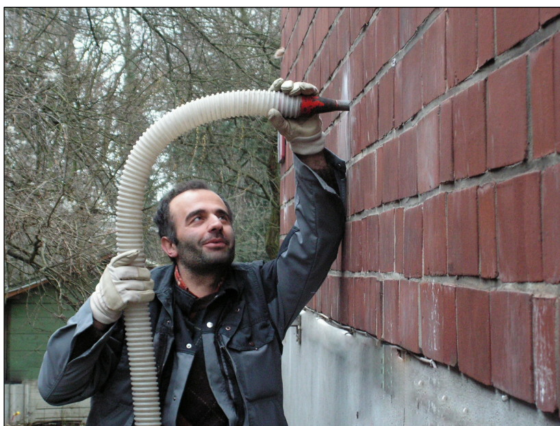
Abb. 3: Einblasdämmung verzehnfacht den Wärmeschutz der Luftschicht
