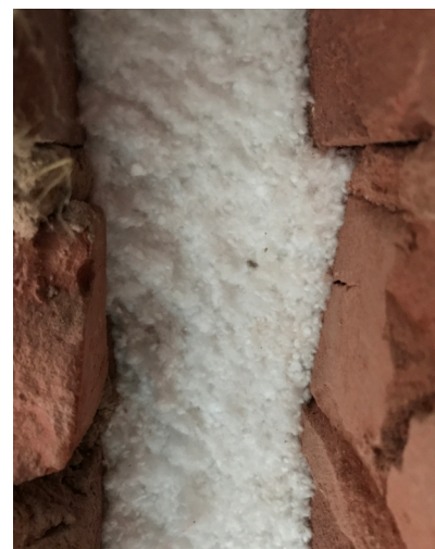
Abb. 4: Luftschichten in Außenwänden sind ein Problem, nicht die Lösung und deshalb hier bereits gedämmt.
