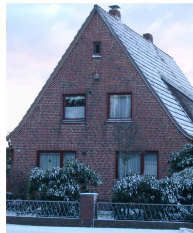
Abb. 6: Durch Klinkerriemchen auf einem WDVS entsteht wieder eine Anmutung des Sichtmauerwerks.
